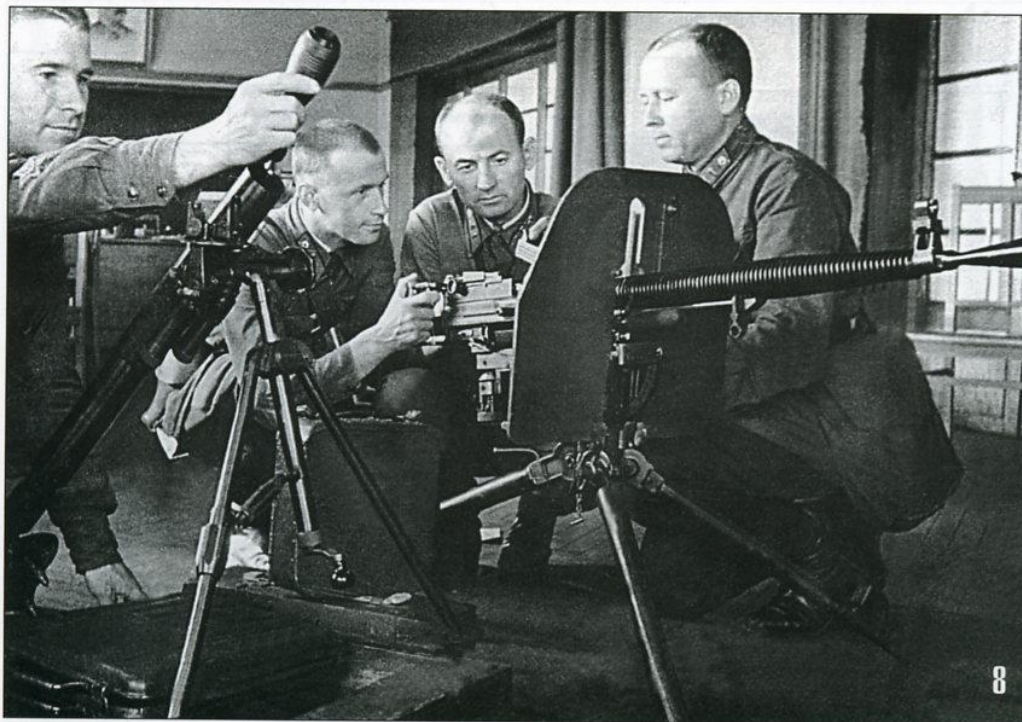
8. Командиры политического состава РККА на курсах Военной академии им. М.В. Фрунзе изучают устройство 50-мм ротного миномета образца 1938 года (слева) 7,62-мм станкового пулемета конструкции Дегтярева (ДС). Москва, июнь 1941 года (АВЛ).
